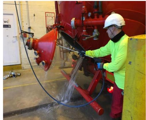
E78 Lavado de alta presión de tapas de carga y descarga, bordes y todos sus componentes incluidos.
